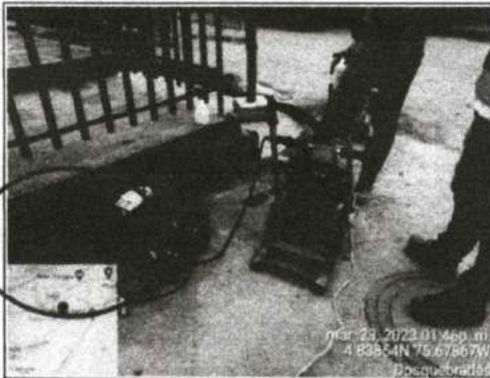
Evidencia de socavón y grietas preexistente Marzo de 2023
