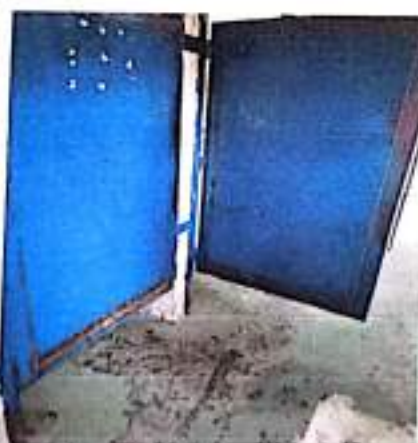
Puertas de baños
